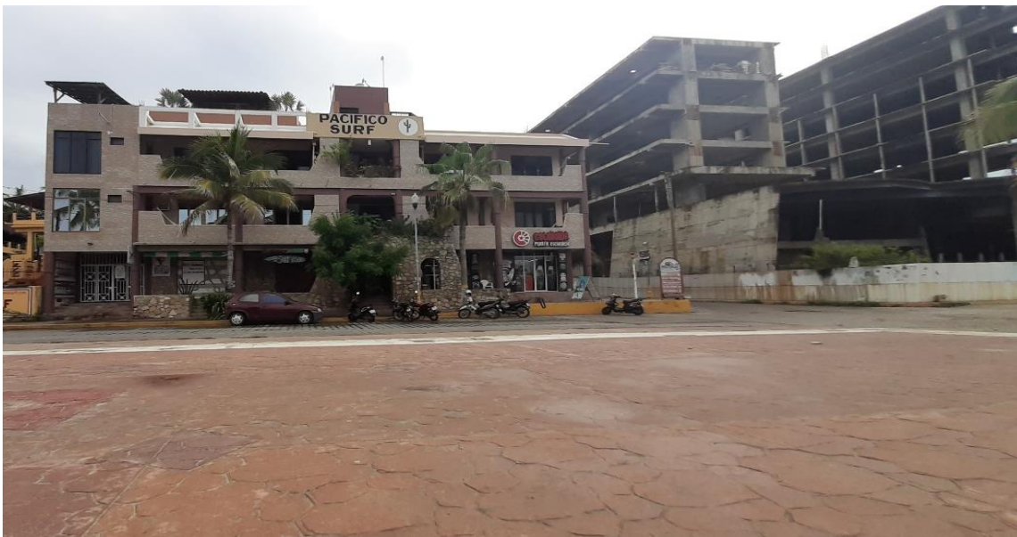
Fotografía 11 Construcción de gran tamaño en el corredor de Zicatela
